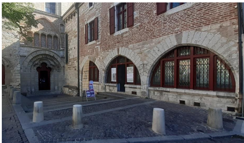
Figure 19 - Entrée de la Prévôté © LEROY Charlotte, 2023
